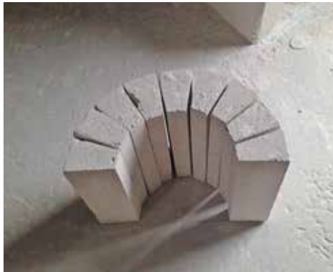
Un travail d'orfèvre : la découpe des blocs de Multipor pour épouser les formes des murs, des ogives...
