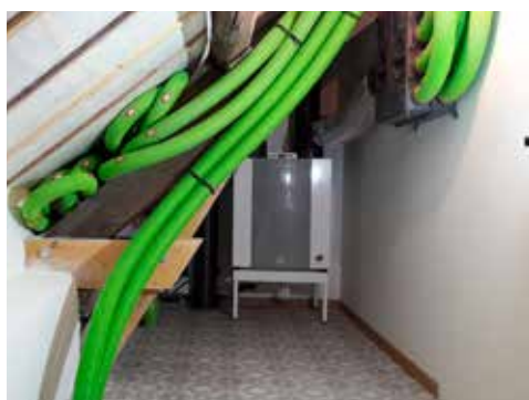
Surélévation de la charpente et VMC installée.
